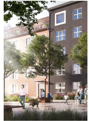
KV 2:5, RIKSBYGGEN, BRUNNBERG & FORSHED
